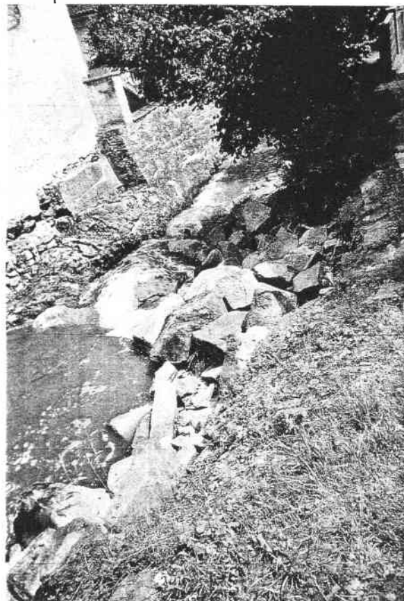
opět byla LÁVKA
